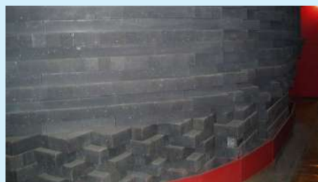
Графитовая кладка реактора Ф-1
