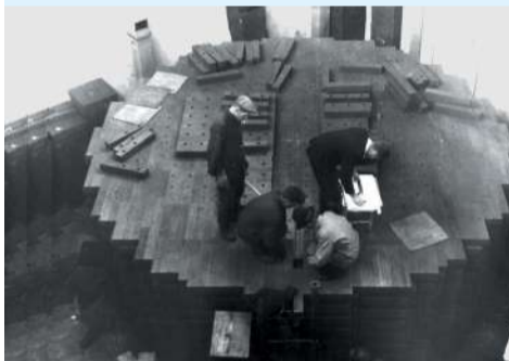
Монтаж реактора Ф-1
